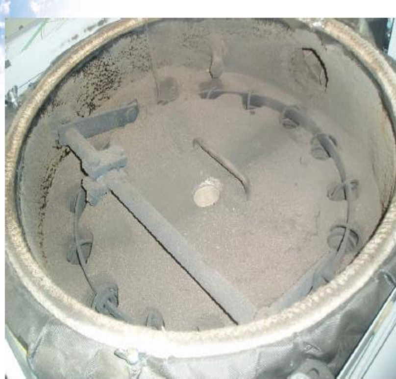
Caldera 20 kW con 2000h funcionamiento antes de limpieza anual
